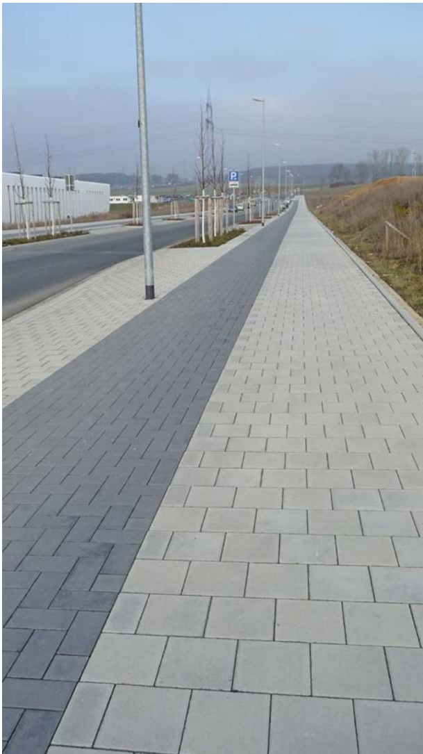
Photokatalytisch wirksames Pflaster lässt sich auf angrenzenden Flächen an viel befahrenen Straßen einsetzen. So werden die Schadstoffe direkt dort abgebaut, wo sie entstehen.
