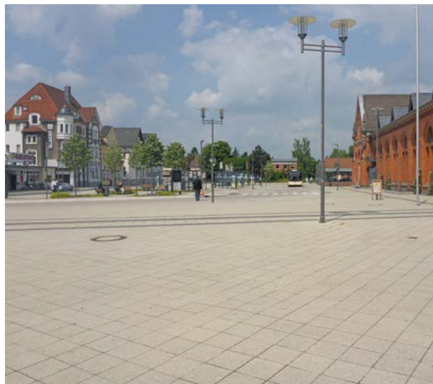
ZOB Detmold, Betonpflasterflächen mit \text{TiO}_2 -Beschichtung.
